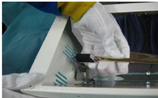
3. DEBLOQUER DES RESSORTS DE TENUE LES JOINTS SILICONIQUES QUI RECOUVRENT LES DEUX EXTREMITES DE L'AMPOULE
